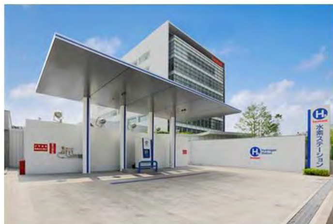
日本初の商用水素ステーション(尼崎水素ステーション)
