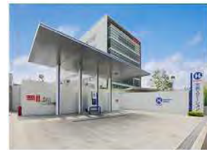
日本初の商用水素ステーション (尼崎水素ステーション)
