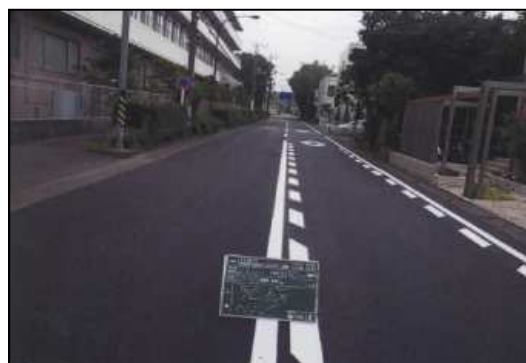
舗装の打ち換え
