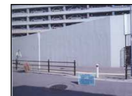
カーブミラーの 設置
