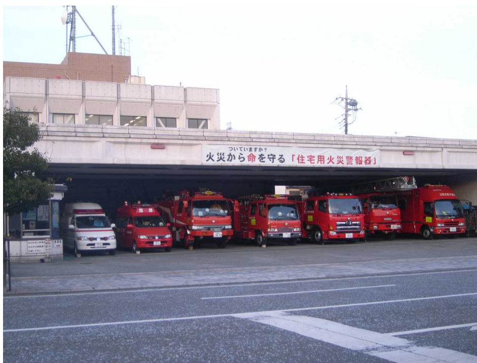
消防署の車庫
