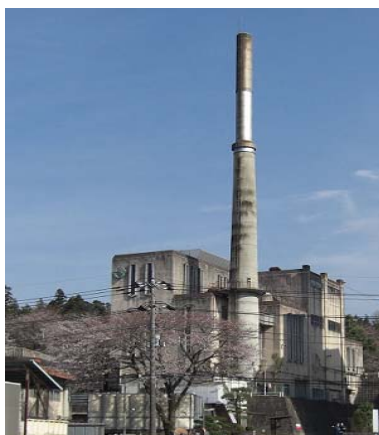
(旧ごみ焼却施設)
