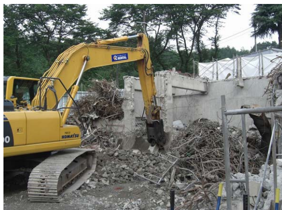
(旧ごみ焼却施設解体)
