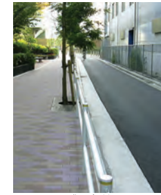
スラグの有効利用(道路の舗装)
