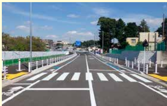
都市計画道路宮上横山線道路改良工事
