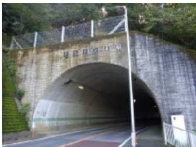
<平丸トンネル>
