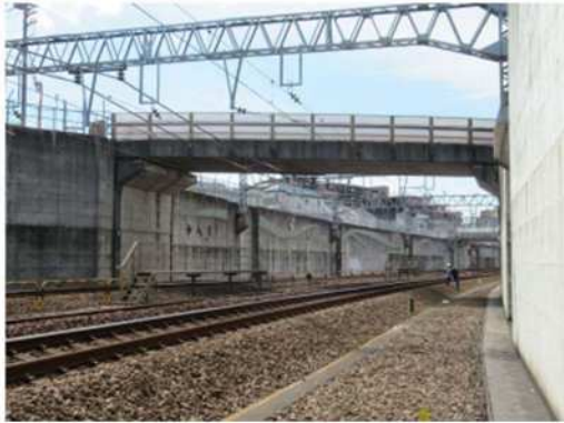
<平成中村跨線橋>
