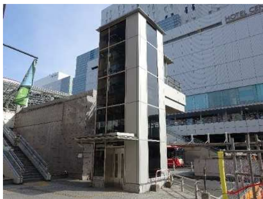
<相模大野駅北口：エレベーター>
