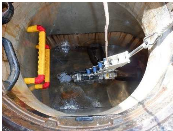
管きょの点検・調査（テレビカメラ調査）
