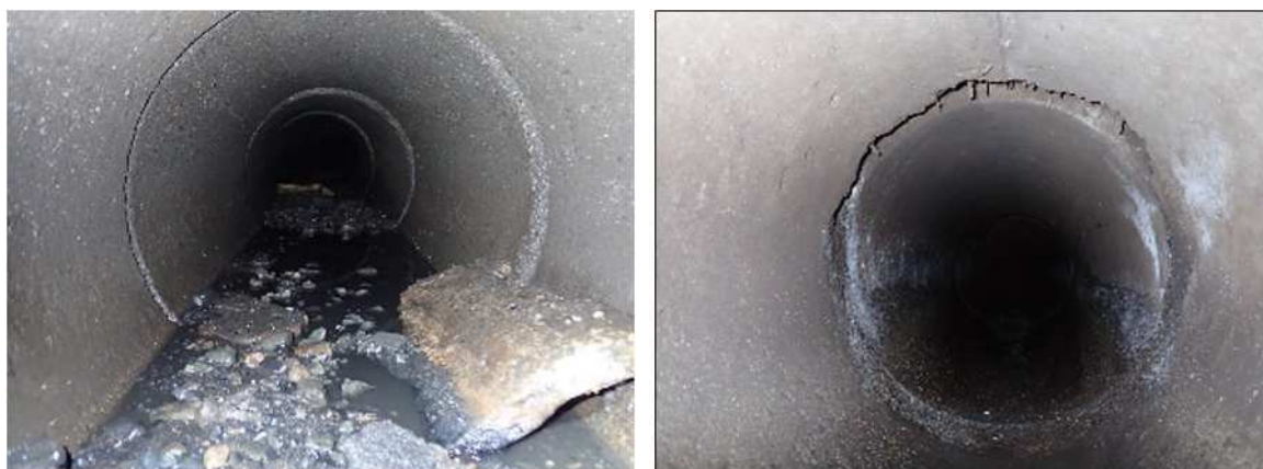
管路施設の老朽化状況
