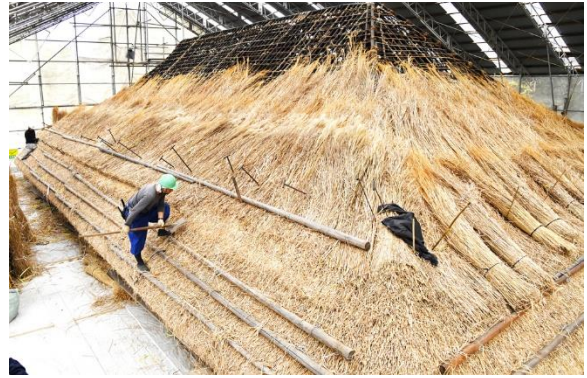
図 4-3 旧青柳庫裏の屋根葺き替え修理
