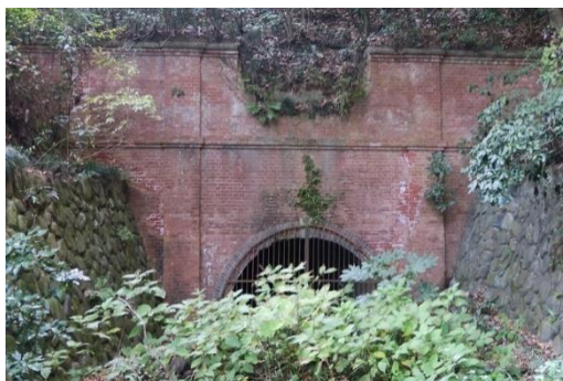
図 3-8 横浜水道 川尻隧道下口
