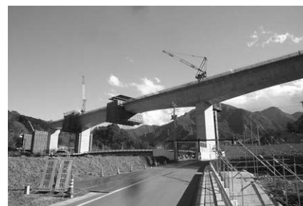
延伸工事が進む山梨リニア実験線
