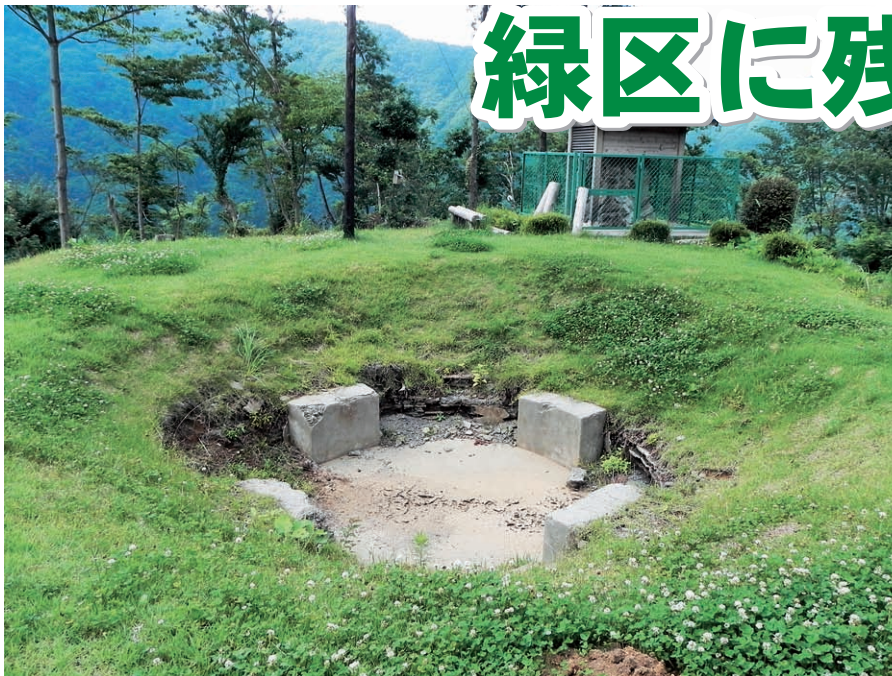
山梨方面の山々も望める青根の監視硝跡
