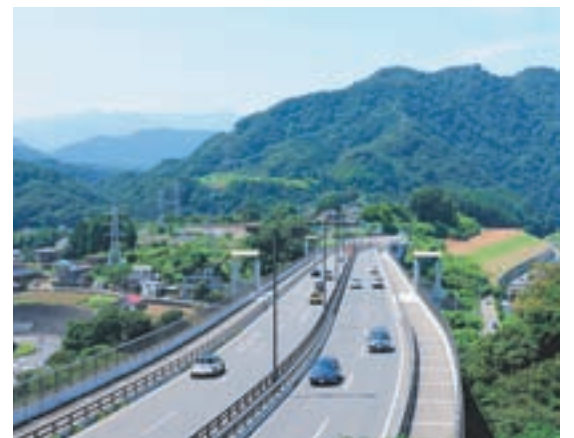
▲津久井広域道路は、国道16号の橋本五差路付近から国道20号の中央自動車道相模湖インターチェンジ付近までを結ぶ幹線道路。さがみ縦貫道路へのアクセス道路として建設を進めています
