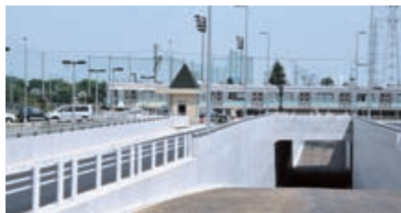
▲9月11日の開通をめざして整備が進む大山氷川線。 写真は相模線との立体交差部分
