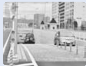
開通した橋本小山ふれあい立体
