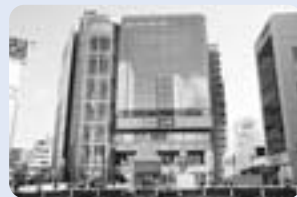
② 橋本図書館など文化施設と商業施設の複合ビル
