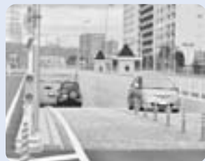
開通した橋本小山ふれあい立体
