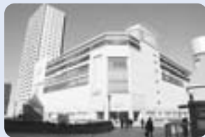
① 緑区役所など公共施設と商業施設の複合ビル
