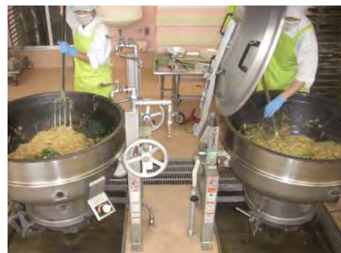
【給食室内回転釜を使用している様子】
