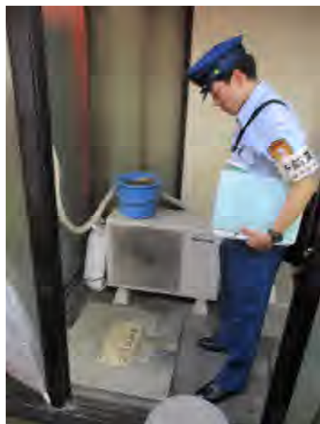
消防用設備等の確認状況 (避難器具)
