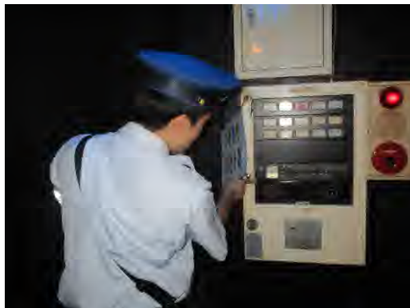
消防用設備等の確認状況 (自動火災報知設備)
