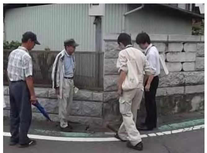
側溝蓋を点検する様子
