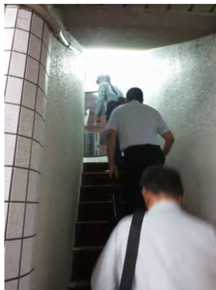
避難階段の確認状況
