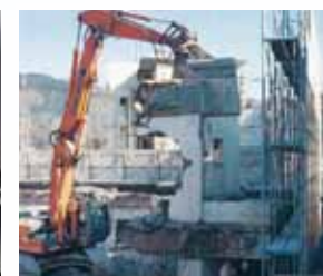
解体作業の様子
