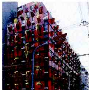
壁面緑化をデザインした建物
