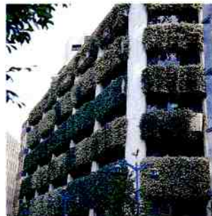
壁面緑化により個性化を図っている建物
