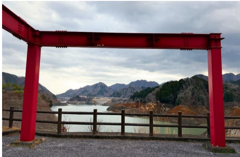
「フレームの向こう側」鳥居原ふれあいの館 鉄鋼物の隙間から見る渇水したダムの様子が強く印象に残った。
