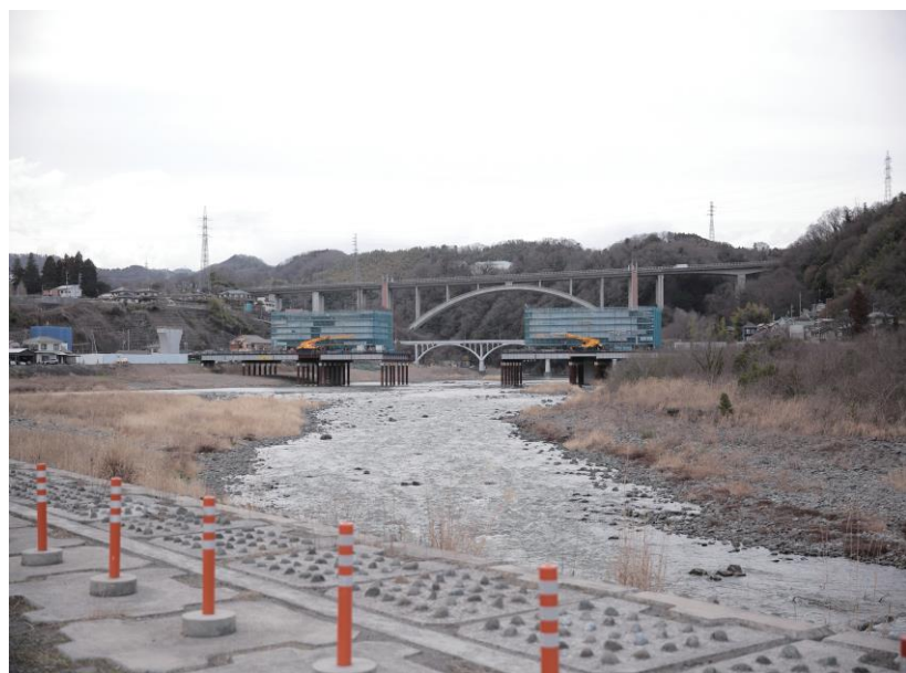
「大島中洲から新旧小倉橋と建設中のリニアを望む」 たのしみですねえ
