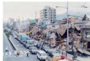
阪神・淡路大震災における建物被害
