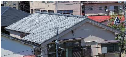
健全な瓦屋根
