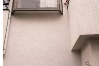
健全な外壁（ひび割れ等がない）
