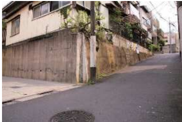
擁壁や坂に面する
