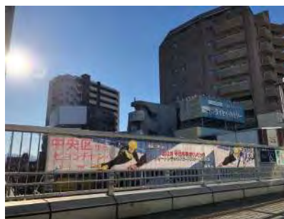
JR 相模原駅ペDESTリアンデッキ
