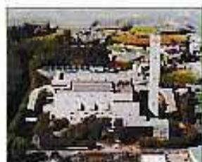
北清掃工場 ＜緑区下九沢＞ごみ焼却・粗大ごみ破砕施設
