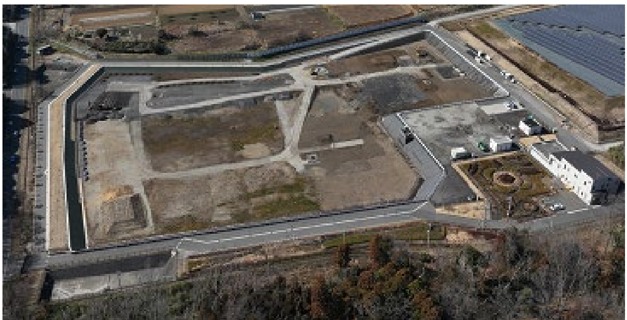
相模原市一般廃棄物最終処分場（シゲンジャーパーク）埋め立て状況 令和7年2月14日現在 埋め立て率51.69%
