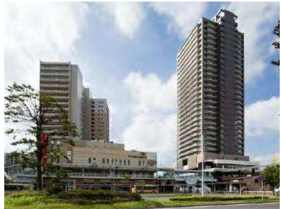
小田急相模原駅北口A地区・B地区 (A地区平成19年完了、B地区平成25年完了)
