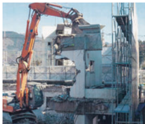
解体作業の様子
