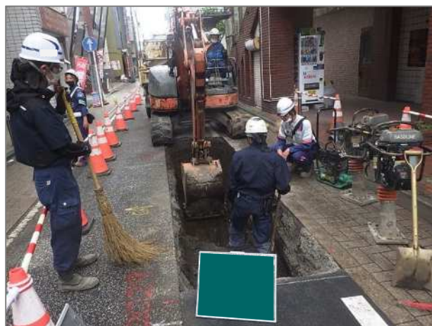
店舗周辺での施工状況
