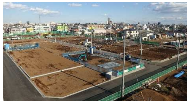
現在、一部の宅地において、個々の権利者様により、住宅建築が進められています。
