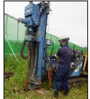
【ボーリング作業状況】
