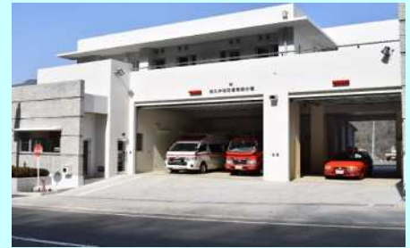
平成30年4月に移転整備した青根分署
