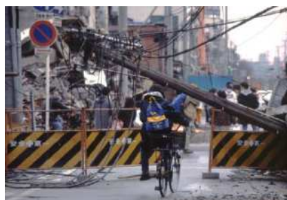
図5-2 道路を塞ぐ電柱（阪神・淡路大震災） (出典：国土交通省ホームページ)
