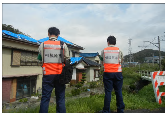
本市職員による家屋被害認定調査の実施状況
