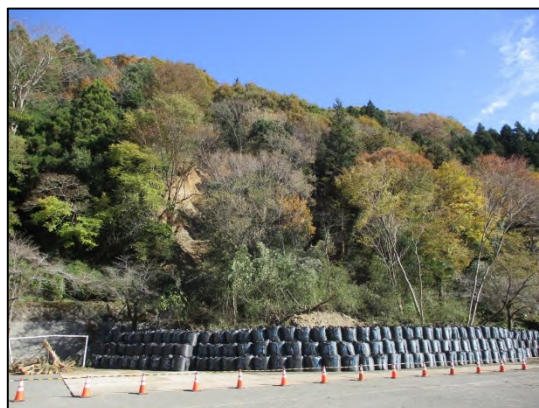
大型土嚢設置後（11月18日撮影）
