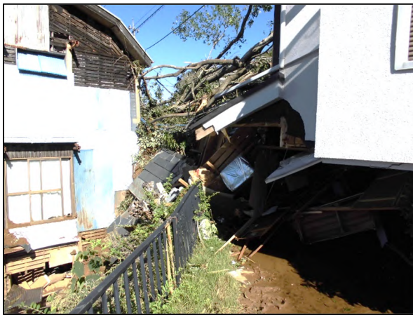
救助現場となった家屋（13日朝撮影）
