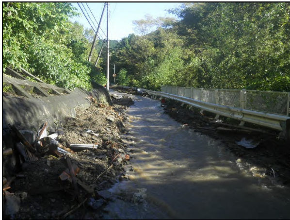
現場へ向かう道路の状況①
