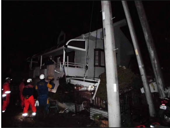
救助現場となった家屋（現場到着時）
