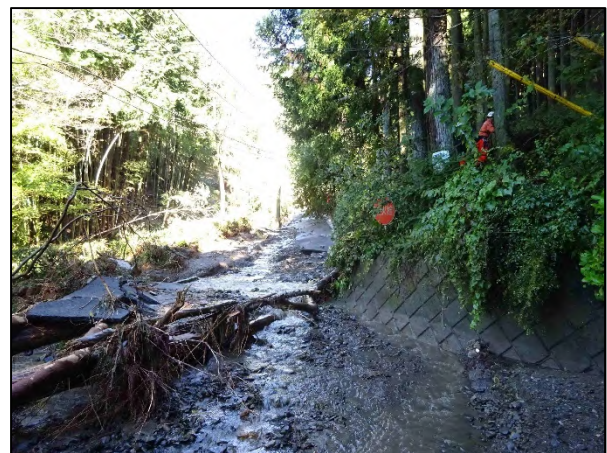
現場へ向かう道路の状況②
