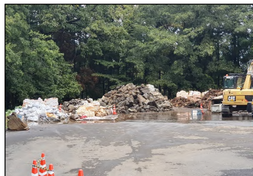
がれき等の受入れ状況（11月11日撮影）
