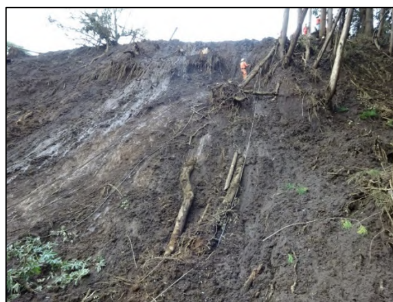
斜面降下により進入する様子
