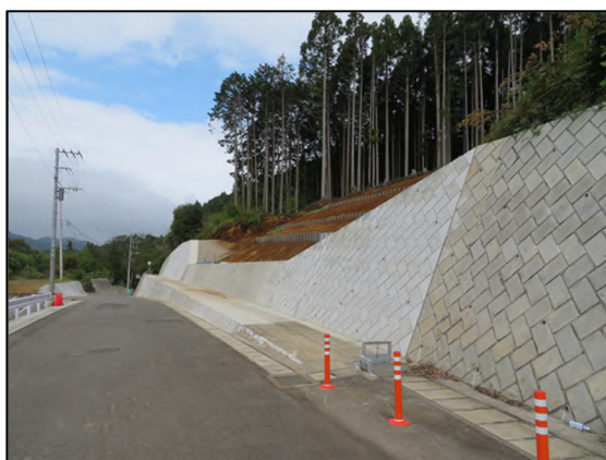
市道復旧及び治山事業施工後
