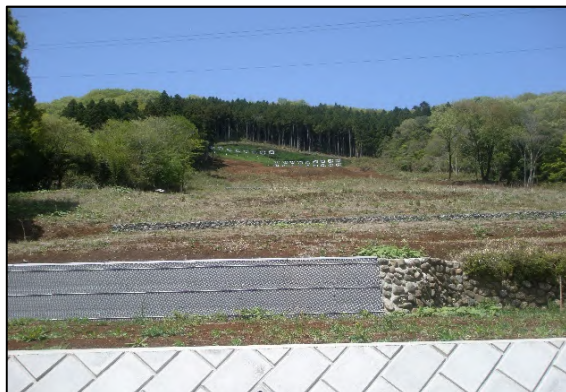
山腹、農地の復旧状況
