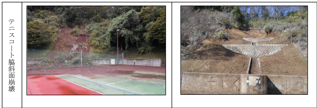
図表 4.8.4 青野原グラウンドの復旧状況
