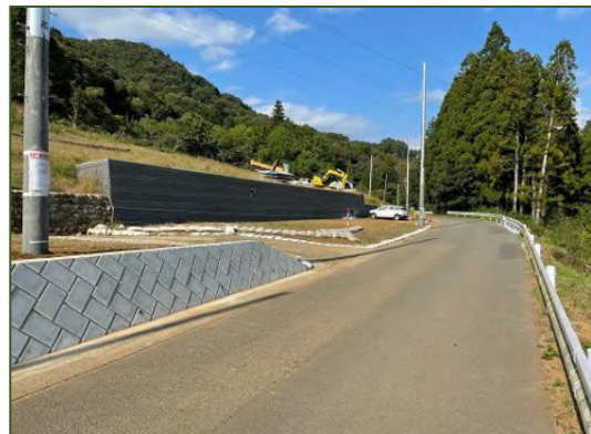
道路の復旧状況
