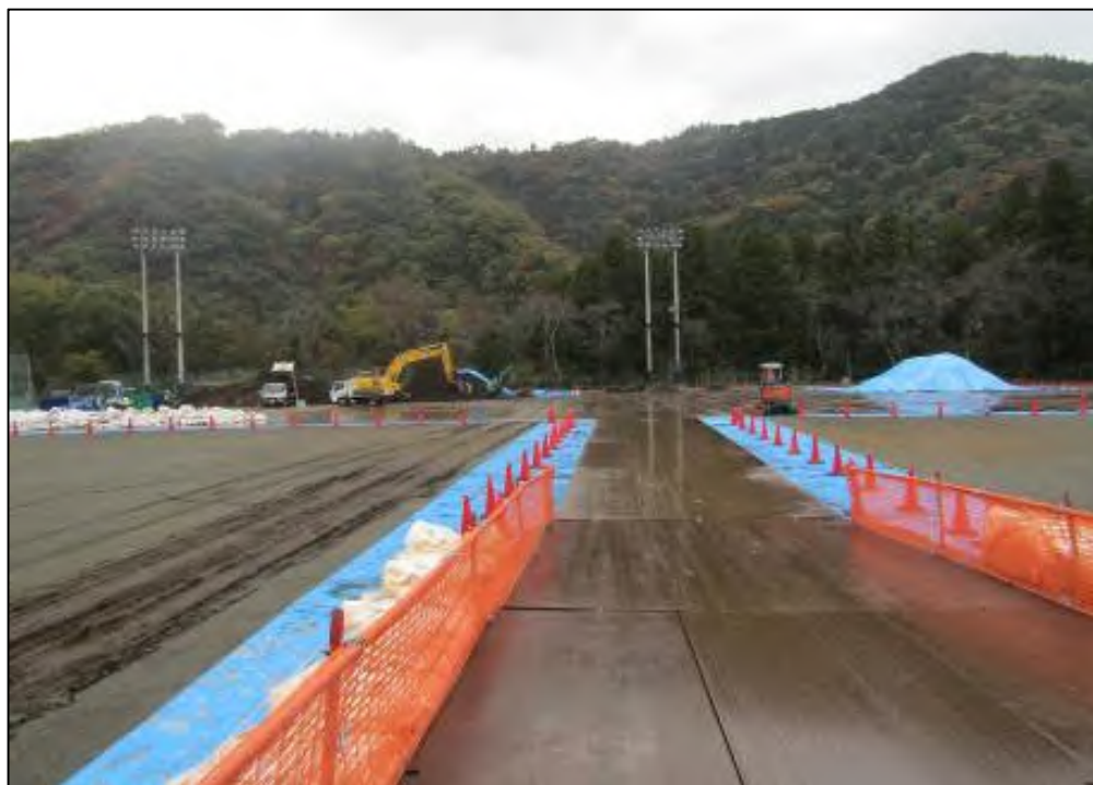
青野原グラウンド（搬入用のスロープを設置）（11月13日撮影）
