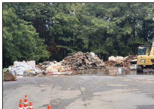
がれき等の受入れ状況（11月11日撮影）
