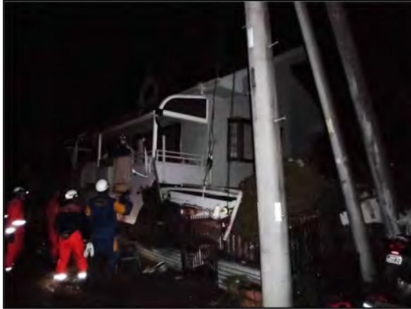
救助現場となった家屋（現場到着時）
