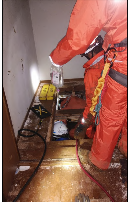
2階床部分を切断して1階へ進入し、狭い空間で救助活動を実施している状況
