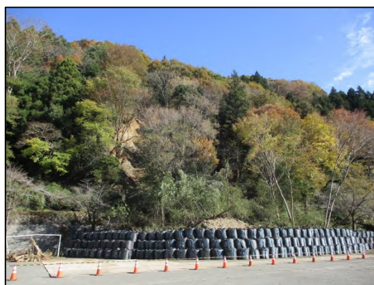
大型土嚢設置後（11月18日撮影）
