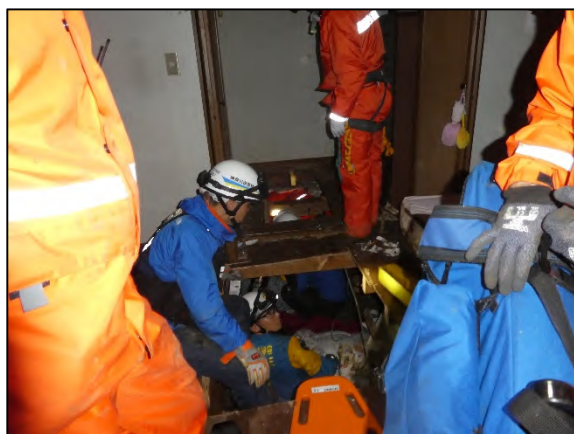
緑区牧野の家屋倒壊現場における救助活動の様子
