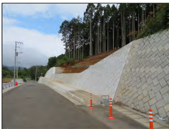
市道復旧及び治山事業施工後
