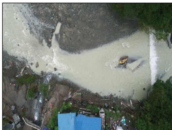
ドローンによる上空からの撮影
