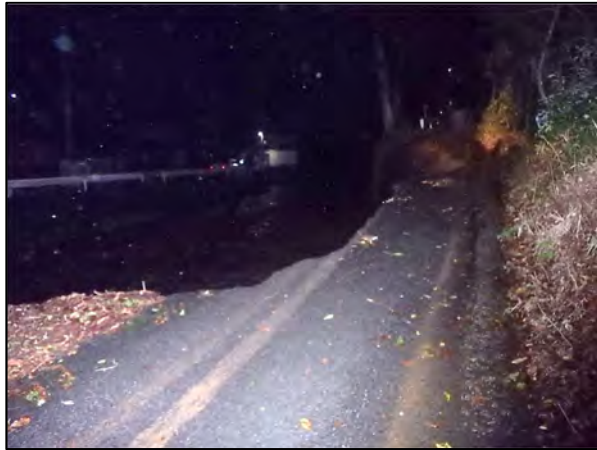
車両転落場所付近
