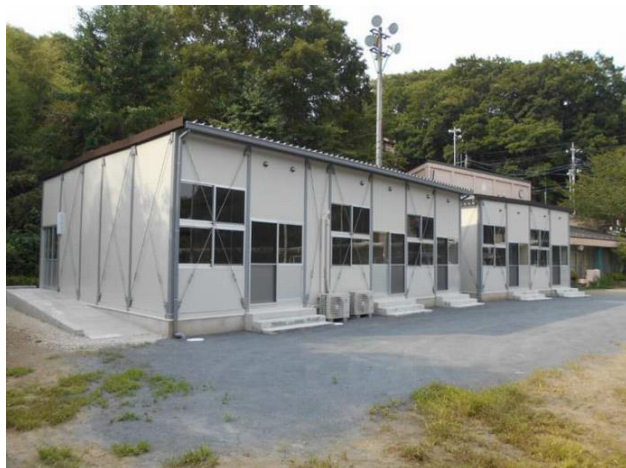
【仮設校舎全景】
