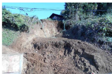
(進入路の法面)
