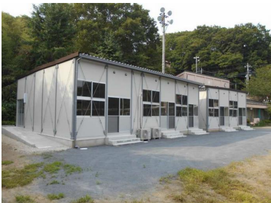
【仮設校舎全景】
