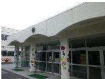
外壁は手入れされているが塗装の浮きふくれ等劣化が進行している
