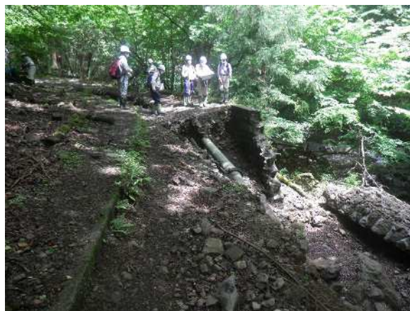
かながわ市町村林政サポートセンターを交え、被災林道の復旧について合同現地検討 （相模原市緑区鳥屋地内）
