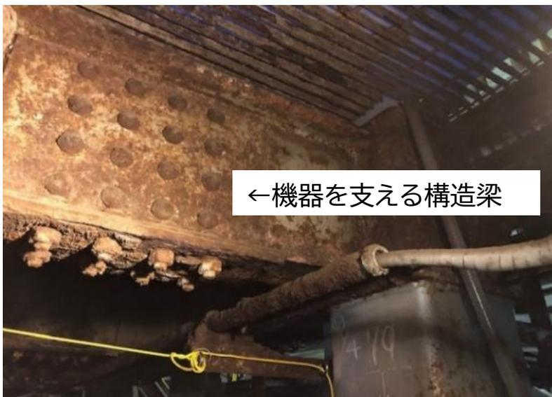
建物構造部の劣化状況(飛灰処理設備)
