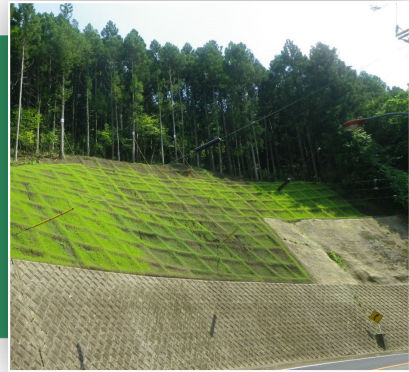
【急傾斜地崩壊対策】
