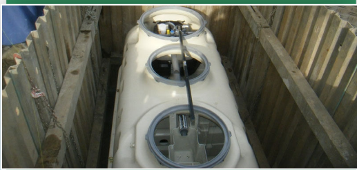
【高度処理型浄化槽】
