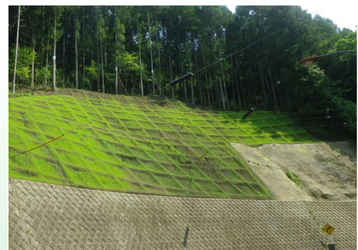
【急傾斜地崩壊対策】
