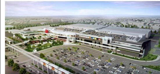
事例：ららぽーと立川(立川市) [地上3階、延べ面積15万㎡] 出典：三井不動産 HP ( https://www.mitsufudosan.co.jp/corporate/news/2015/1008_01/ )
