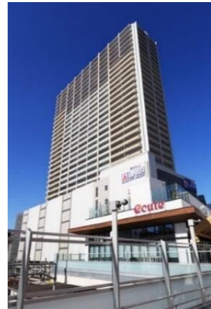
事例：プライドタワー立川(立川市) [地上32階、319戸] 出典：日本の超高層ビル ( https://skyskysky.net/construction/201631.html )
