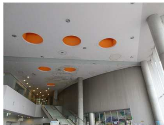
1階ホールの天井
