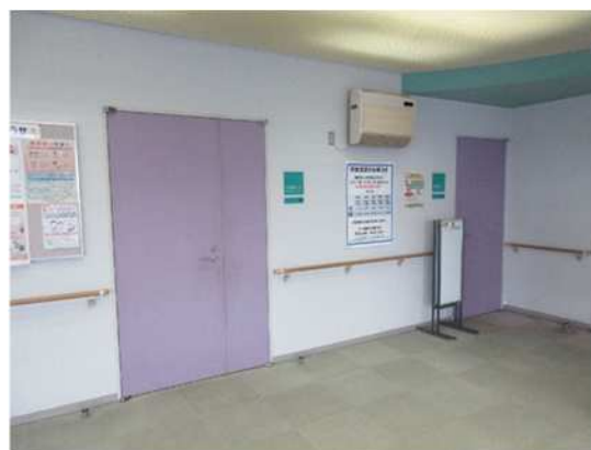
2階多目的会議室(会議室内の活動が分からない)
