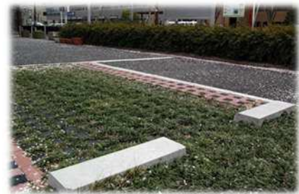
環境情報センターにおける駐車場緑化
