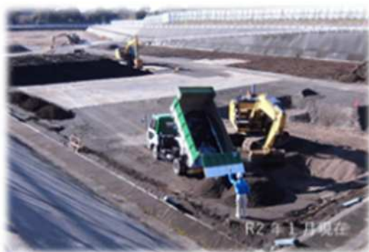
一般廃棄物最終処分場(第2期整備地)
