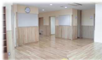
木材の利用促進（橋本こどもセンター （腰壁に津久井産材を使用））
