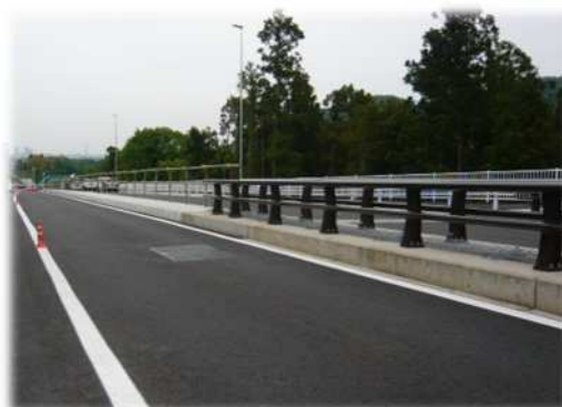
スラグ入りアスファルト舗装(津久井広域道路)
