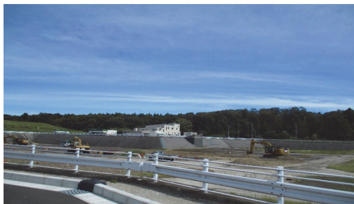
一般廃棄物最終処分場（第2期整備地）
