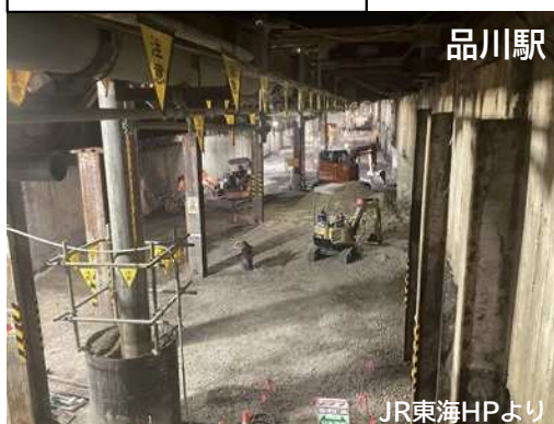
各中間駅の進捗状況
