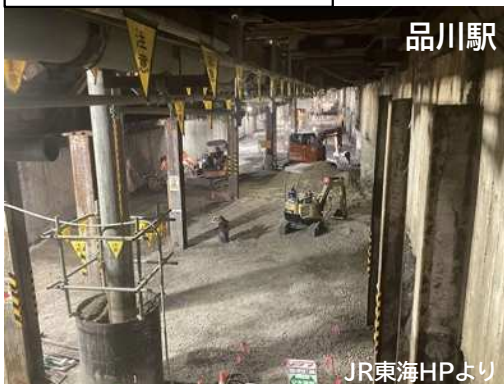
各中間駅の進捗状況
