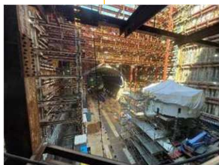
組立中のシールドマシン
